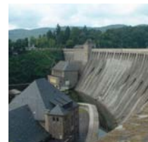
Stuwmuur van waterenergiecentrale Edersee, door Philip Holzmann AG, 1908-1914
